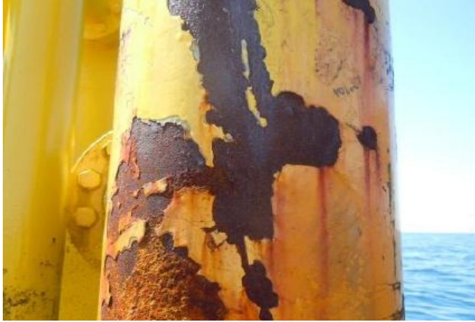
Häufiges Erscheinungsbild: Abplatzungen, Unterwanderung und Korrosion (Foto Heins, EnBW)
