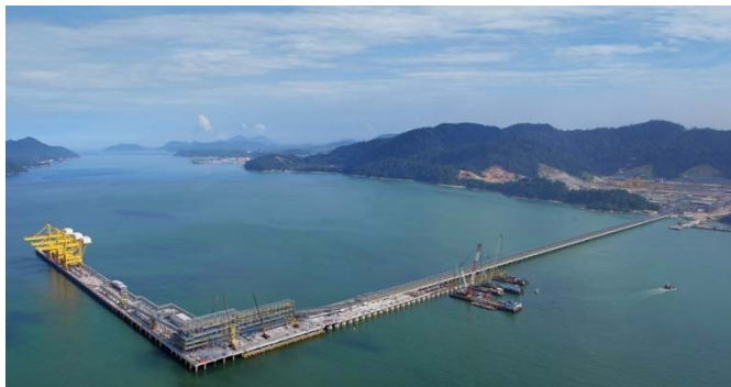
Bild E 223-1: Beispiel einer fest installierten Anlegebrücke, Lumut (Malaysia) [BAM International]
