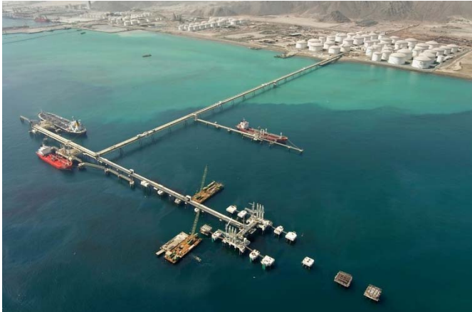
Bild E 223-6: Beispiel einer Zugangsbrücke, Fujairah (VAE) [BAM International]
