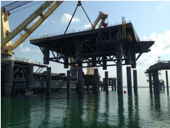
Bild E 223-5: Installation einer an Land gefertigten Plattform, Darwin (Australien) [BAM-Clough]
