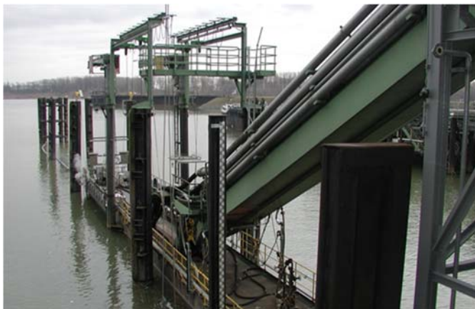
Bild E 223-2: Beispiel einer schwimmenden Anlegebrücke, Köln [Shell Deutschland]
