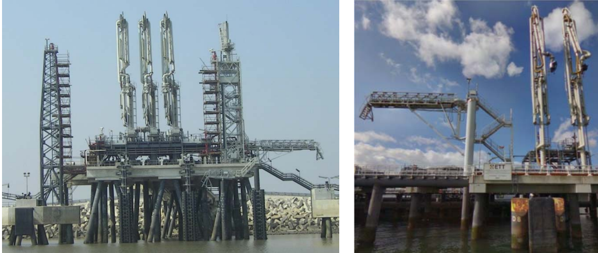
Bild E 223-7: links: Verladearme sowie Türme für Feuerlöschmonitor und Gangway, Gujairat (Indien) [Shell]; rechts: Gangway, Rotterdam [Cyclomedia Technology B.V.]
